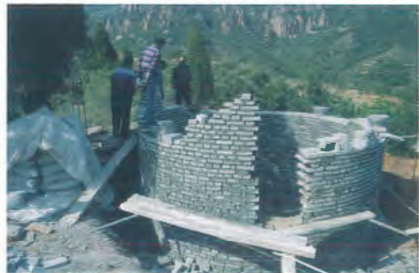
蓄水工程施工
