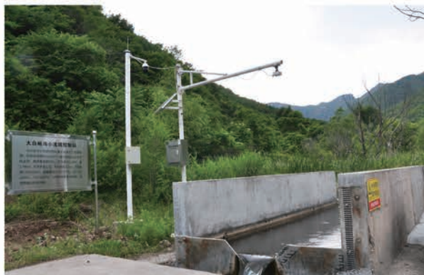
青龙县大暖泉监测站大白峪沟控制站
