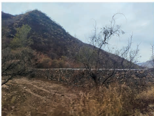
怀来县谷坊工程
