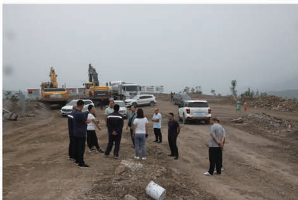
检查矿山项目
